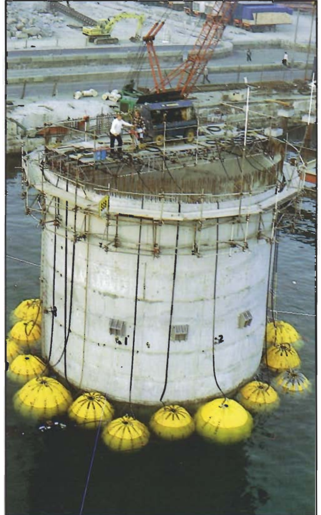
Öppna lyftsäckar modell PR med en total lyftkapacitet på 125 ton användes vid flyttning av en betongkasun. Kasunen har en total vikt på 700 ton är 17 meter hög och har en diameter på 10 meter.
